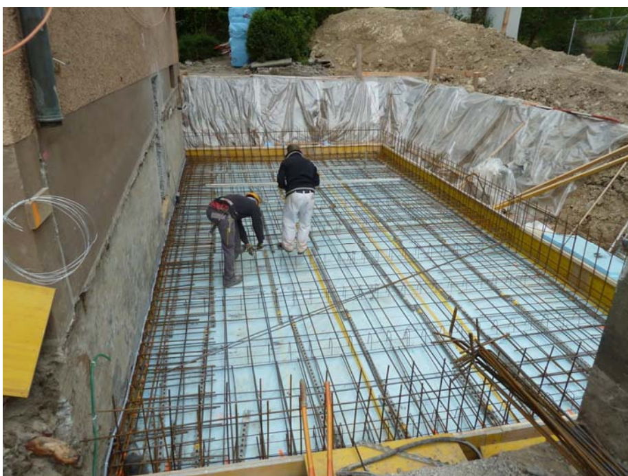
Scheuchzerstrasse 192: Errichten des Fundaments des Anbaus
