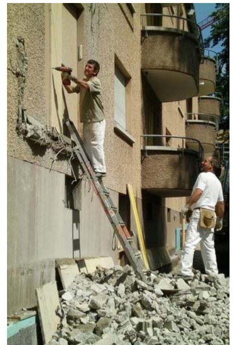
Scheuchzerstr. 188/190: Balkonabbruch
