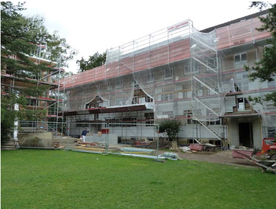
Scheuchzerstrasse 188/190: Anbringen der Wärmedämmung
