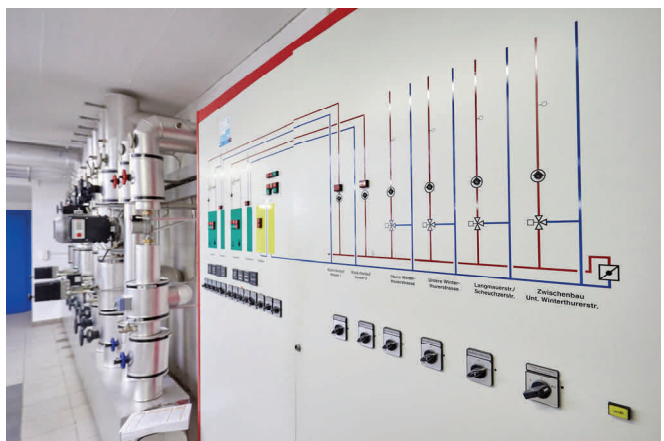
Wird im Zuge des Ersatzneubaus abgerissen: Die BGO-Heizzentrale in der Winterthurerstrasse
