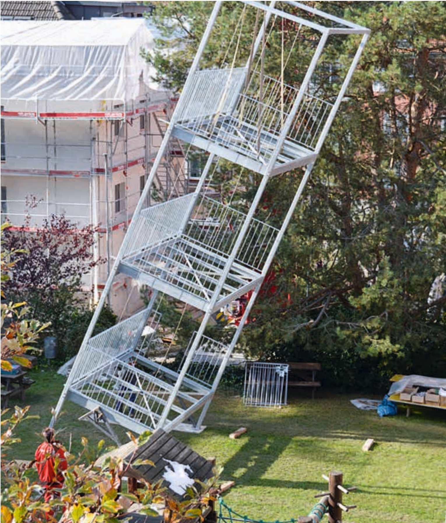
Sind die einzelnen Elemente zusammengefügt, hievt der Baukran den vorgefertigten Balkonturm an seinen Bestimmungsort.
