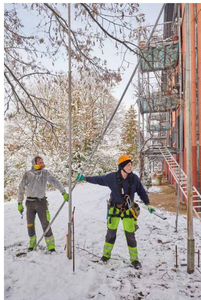
Die Dimensionen des Neubaus werden sichtbar: Ausgesteckte Bauprofile, Winter 2019
